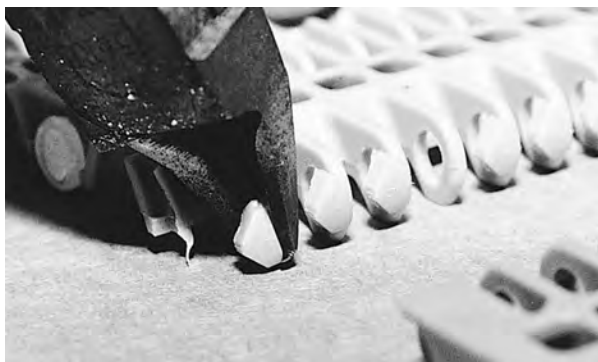
Figuur 27: Verdikking van afstandhouder knippen
